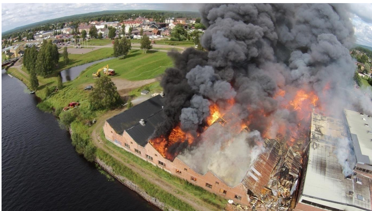
Bild 1: År 2014 inträffade en stor brand på Malungs f.d. garveri under dansbandsveckan. Kombinationen kraftig rök och ett stort antal människor i Malungs centrum ställde höga krav på räddningsledningen och utförandet av räddningsinsatsen.
