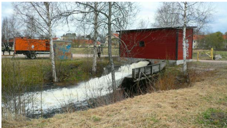
Pumpning vid f.d. lokstallarna i Malung
