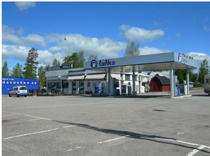
Tidigare tankstation på fastigheten Orrmyrheden 2:2
