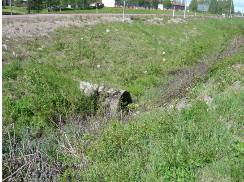
Dike mellan rv.66 och planområdet.
