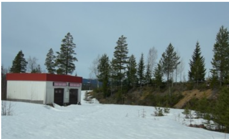
En förfallen verkstadsbyggnad finns i planområdets östra del.
