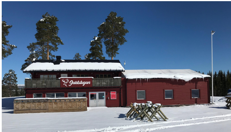
Befintlig restaurangbyggnad Jaktstugan
