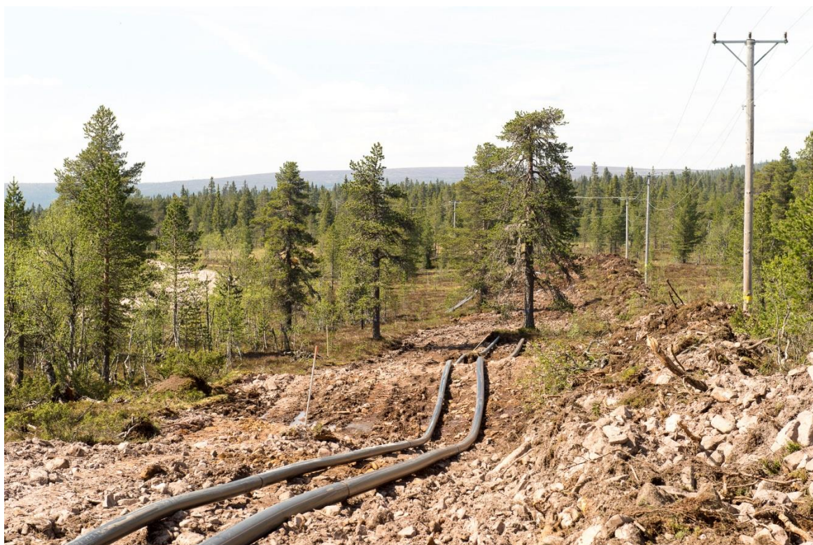
Figur 16. Anläggningsarbete på Flatfjället
