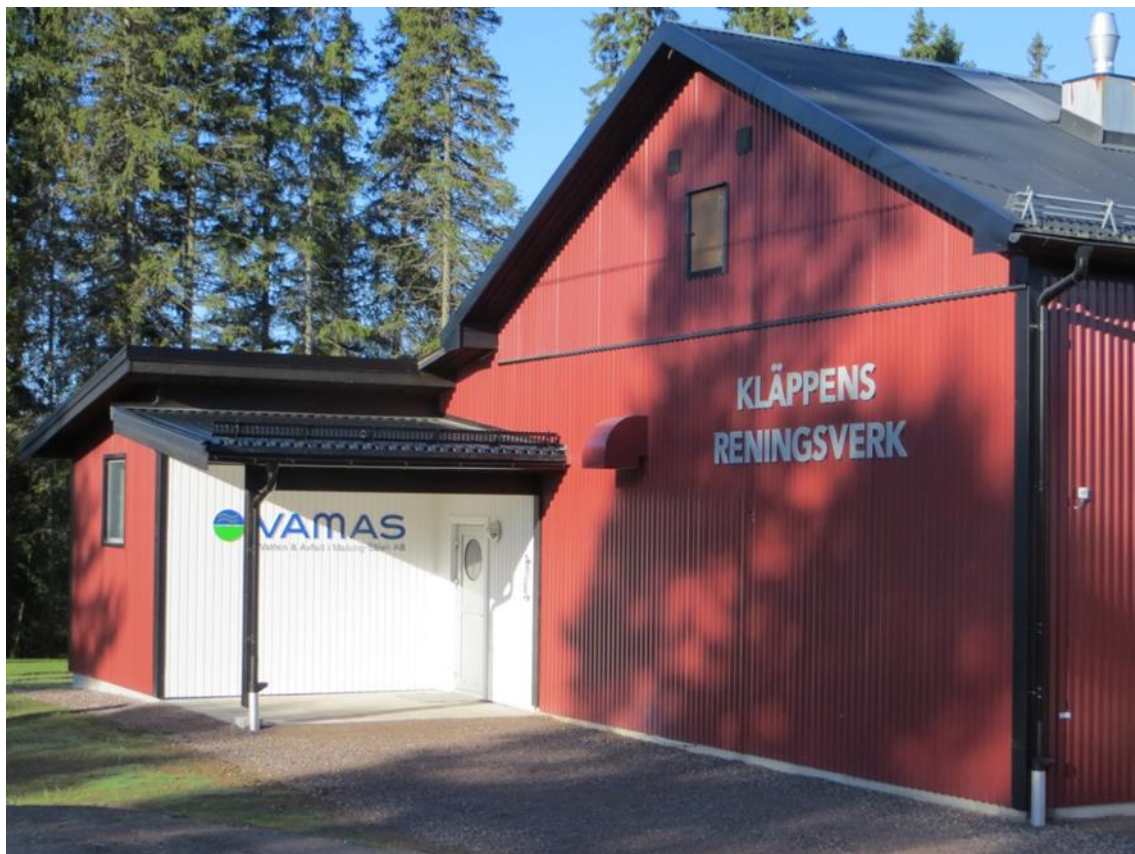
Figur 15. Reningsverket i Kläppen som byggdes 2013
