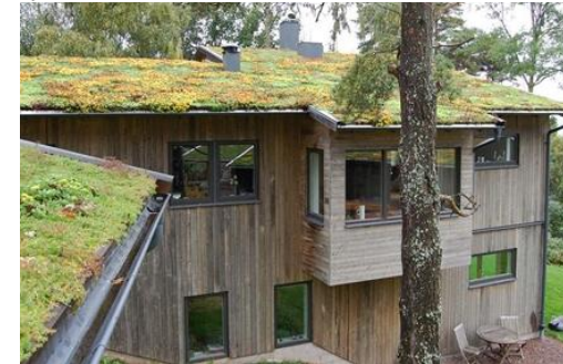
Sedumtak och träfasader
