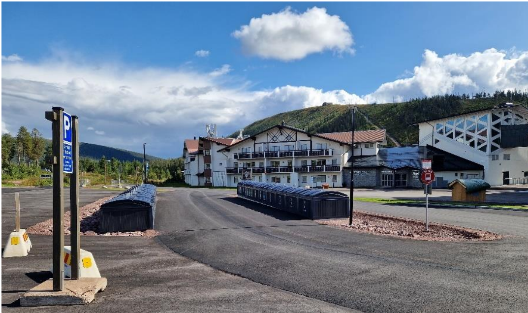
Bild på den nya återvinningsstation som byggt inom planområdet.
