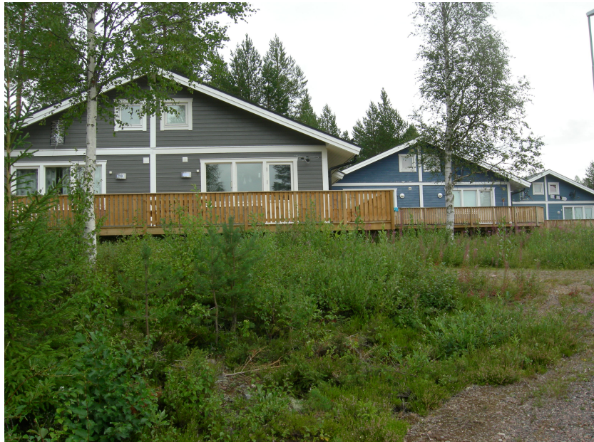
Befintlig stugby öster om Danskvägen. Stugorna har två lägenheter
